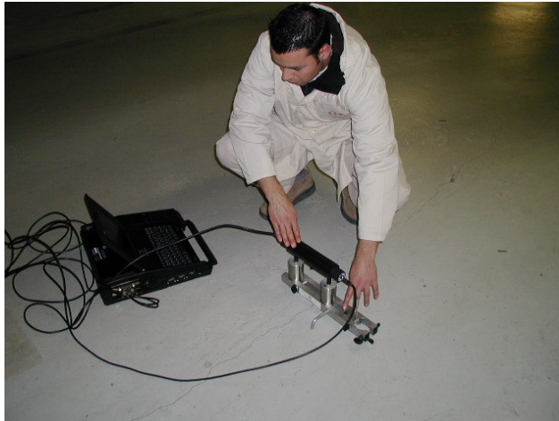
Fig. 3 – Medição da profundidade de fissuras numa laje.
